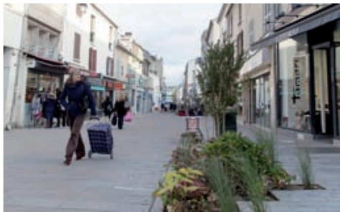
► Les plantations au sol, dont les cerclages se sont révélés gênants pour les piétons, vont être sécurisées pendant l'été.
