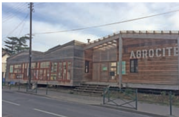
► L'association AAA a désormais six mois pour déconstruire et déménager l'Agrocité, ce qui retarde d'autant la réalisation du parking provisoire.
