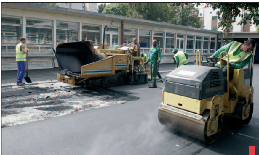
Réfection totale de la cour du bâtiment 2 à l'école Charles Peguy A.
