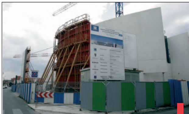
Le chantier du futur collège Robert Paparemborde.
