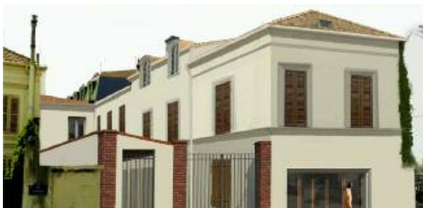
Le bâtiment a été rétrocédé par la municipalité à SNL qui va le restaurer à l'identique. Une opération de grande ampleur.
