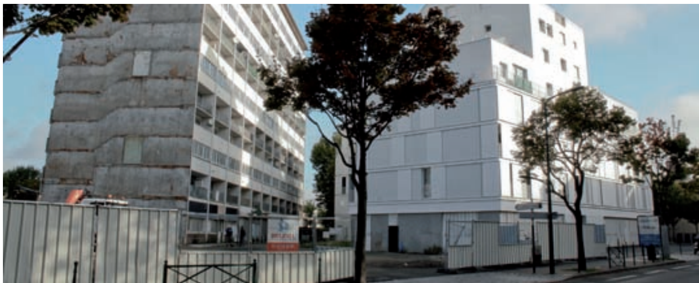
► La déconstruction de la partie restante du grand immeuble se déroulera au premier trimestre 2016.
