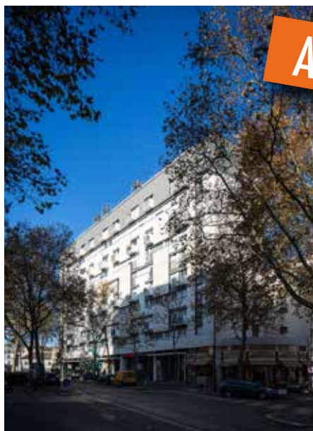
► L'immeuble rénové et un hall, entièrement réaménagé.
