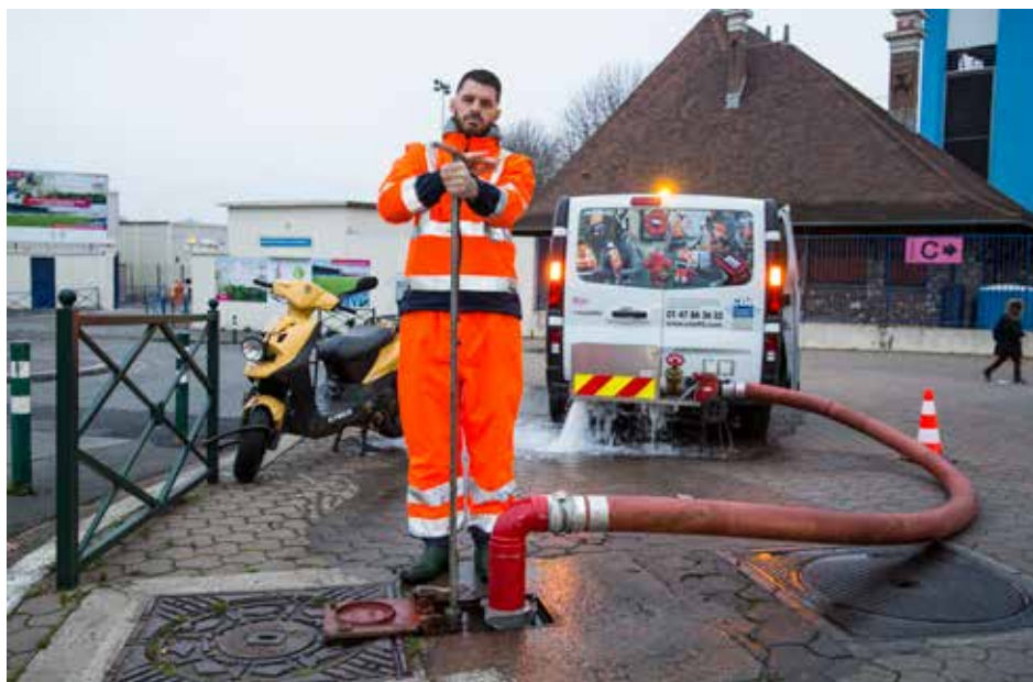
► Les techniciens de CDA sont spécialisés dans les bouches d'incendie des collectivités dont ils assurent la maintenance et le renouvellement, comme ici à Colombes, rue Paul-Bert. Photos Alexis Goudeau
