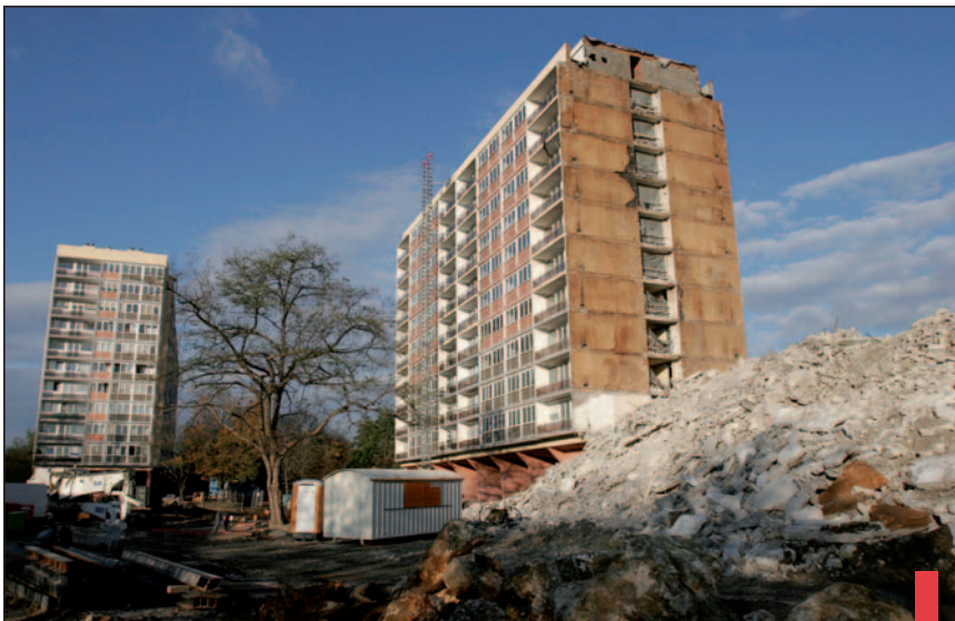
Le chantier après démolition des premiers appartements.
