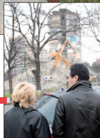
État des lieux de l'avancée des travaux de déconstruction de la première barre de l'Île-Marante.
