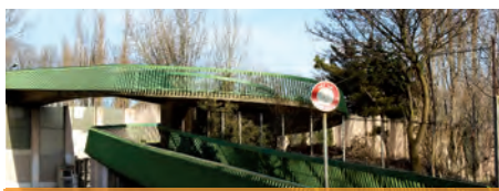
La passerelle donnant sur le parc Lagravère sera réaménagée.
