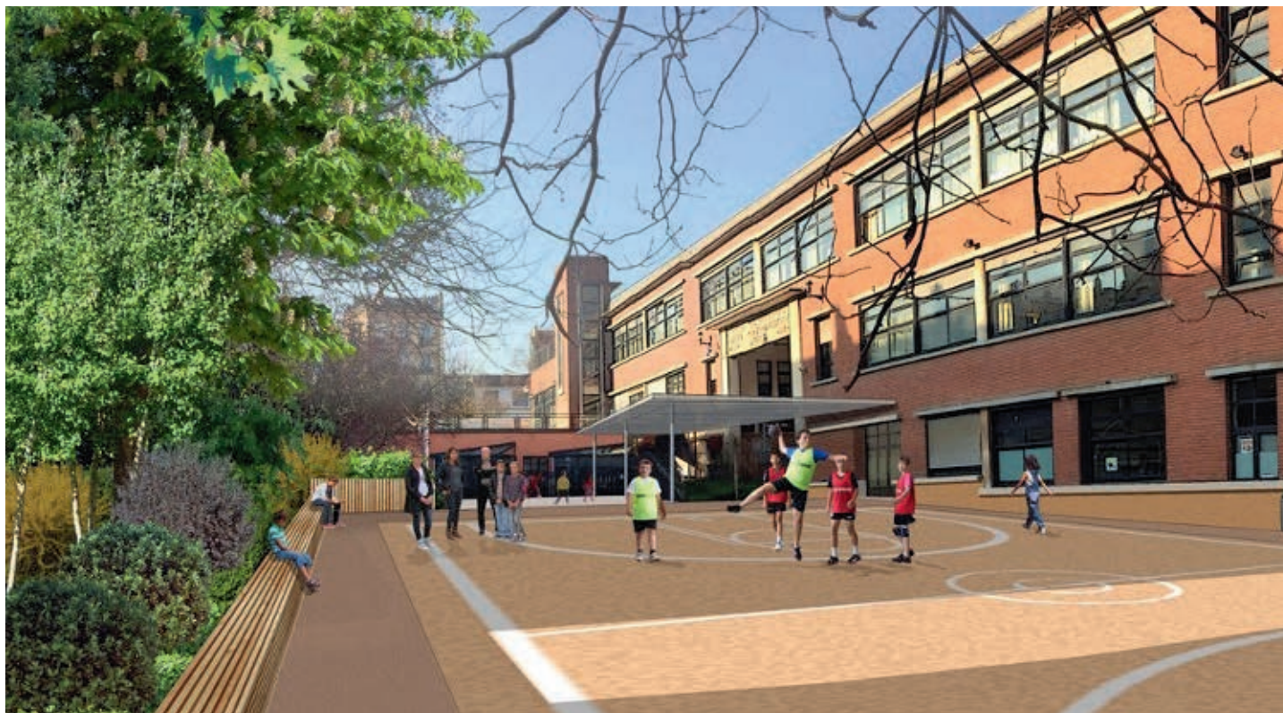
► Le chantier de rénovation et d'extension du groupe scolaire Maintenon bat déjà son plein. La création d'une cour de récréation sur un seul niveau pour les élèves d'élémentaire est notamment prévue pendant les vacances scolaires.
