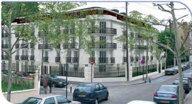
Construction d'un foyer pour adultes en situation de handicap et Maison-relais 81, rue Raymond Ridel
