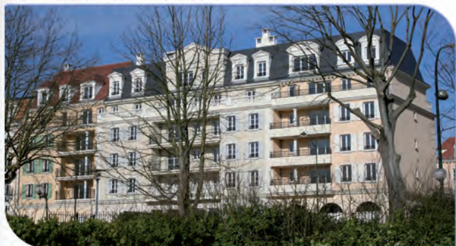
79 logements locatifs sociaux 80 av. Charles de Gaulle et 2-4 rue Saint-Fiacre
