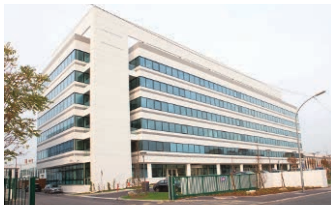
► Le nouveau bâtiment amiral, de 8 700 m², de haute qualité environnementale, génère des économies sur les coûts énergétiques et de maintenance.
