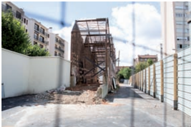
► Les travaux de reconversion sont conçus pour conserver la forme caractéristique de l'édifice, avec sa toiture à redents. Photo Alexis Goudeau.
