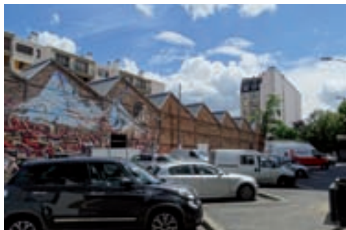
► L'usine Palan, désaffectée depuis une trentaine d'années, est intégrée à la Zac de la Gare. Ici, avant les travaux de réhabilitation.
