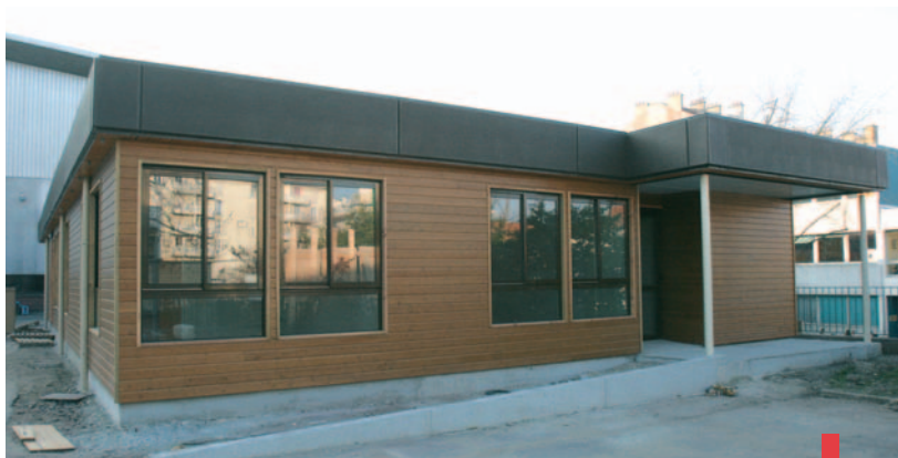
La reconstruction du nouveau centre de loisirs Jacques Brel sera bientôt achevée.
