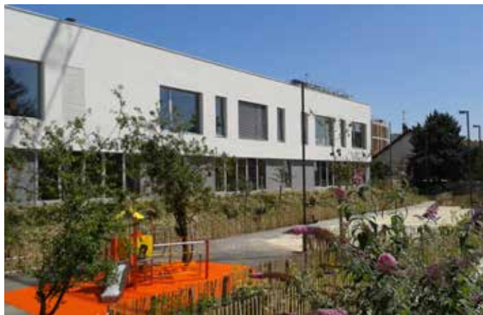
La restructuration du groupe scolaire Jean-Jacques-Rousseau est au cœur des investissements du quartier des Fossés-Jean. Photo Alexis Goudeau
