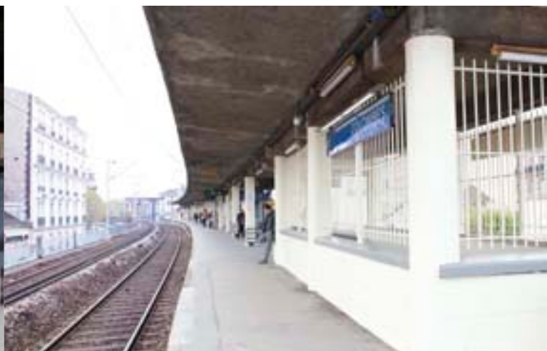
Les travaux de restauration du viaduc ferroviaire entre les gares du Centre et du Stade débuteront en mars 2014.
