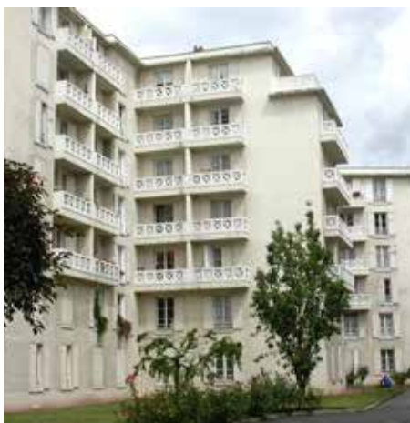
► Rue Paul-Bert, les architectes Croizé et Langelez animent leurs bâtiments d'une touche régionaliste avec des volets en bois.
