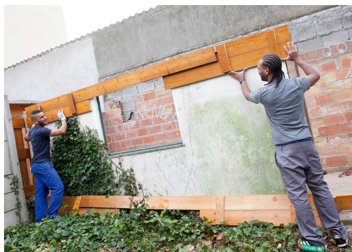
► Maçonnerie, peinture, plomberie, électricité, autant de travaux effectués par les employés.
