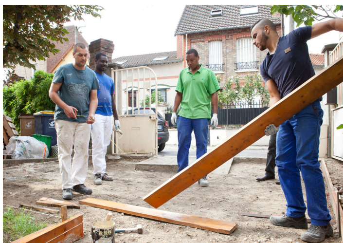
► Les équipes de la Passerelle effectuent également des travaux chez les particuliers.
