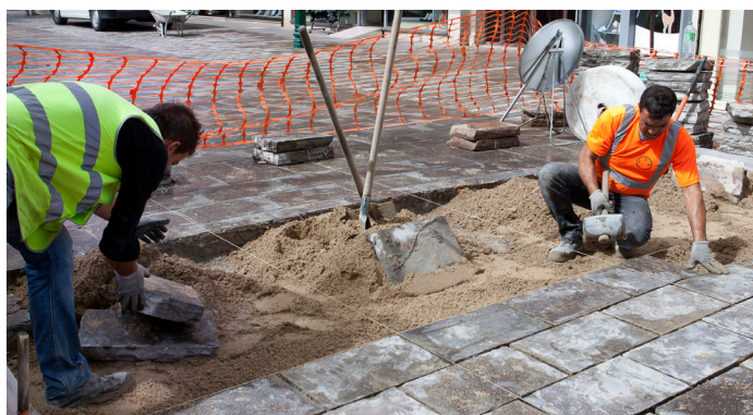
► Les travaux se termineront le 26 septembre.
