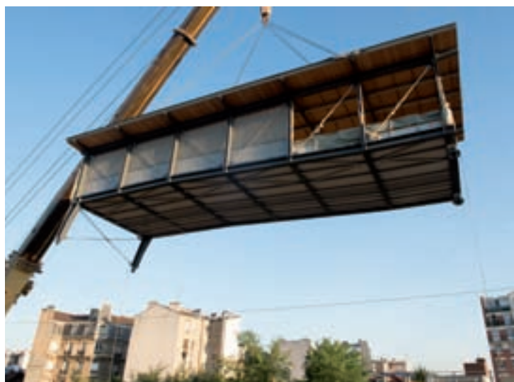
► Une passerelle de 50 tonnes a été installée au-dessus des voies. Photo Martine Mouchy
