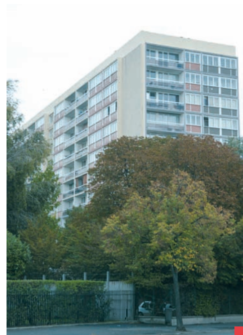
L'une des deux barres de l'Île-Marante avant sa déconstruction sélective.
