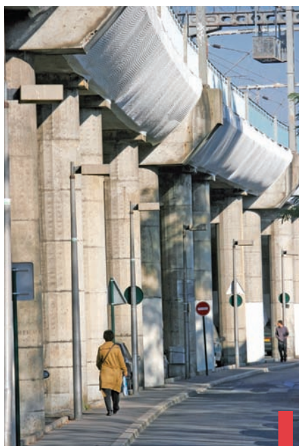
La pose du filet a commencé le 15 octobre.
