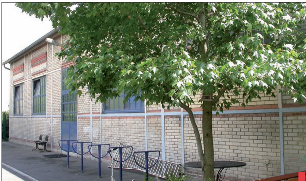
La facade en briques du plus petit équipement sportif de la ville.
