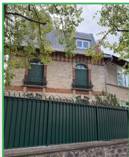
Rénovation de la couverture et remplacement des clôtures, crèche des Colibris
