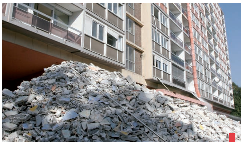
Les logements du premier bâtiment en cours de démantèlement.
