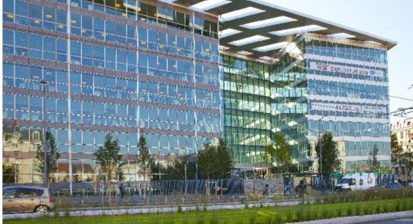
Les Portes de la Défense, en bordure du boulevard Charles-de-Gaulle. Le renforcement du caractère attractif de la ville est un des enjeux qui vont marquer l'année 2012.
