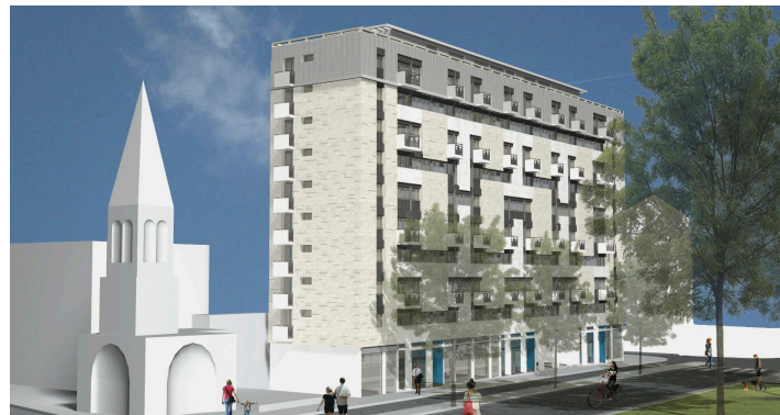
► Propriété de CHP, l'immeuble du 1-3-7 rue du Bournard va être rénové à partir de ce mois de novembre. La réception des travaux est prévue en août 2017.
