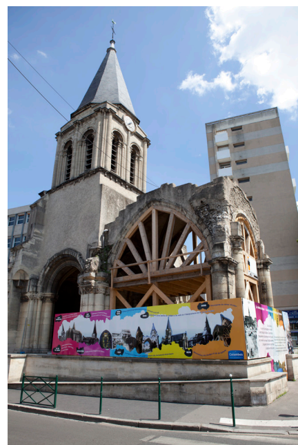
► La rénovation du vieux clocher, projet phare de la municipalité, sera soutenue à hauteur de 500 000 euros par le Département.
