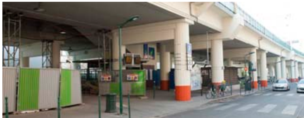
► Le chantier va entraîner en avril une fermeture à la circulation d'une partie du boulevard Gambetta, avant de se poursuivre vers l'avenue Ménélotte.
