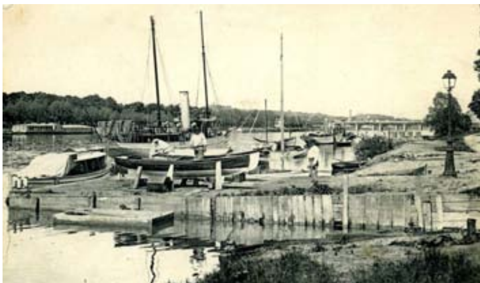
► Les chantiers Luce en aval du Quai du Petit-Gennevilliers, le pont d'Argenteuil à l'arrière-plan.
