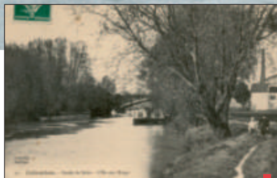
Les berges après le rattachement de l'Île-Marrante archives municipales de Colombes.
