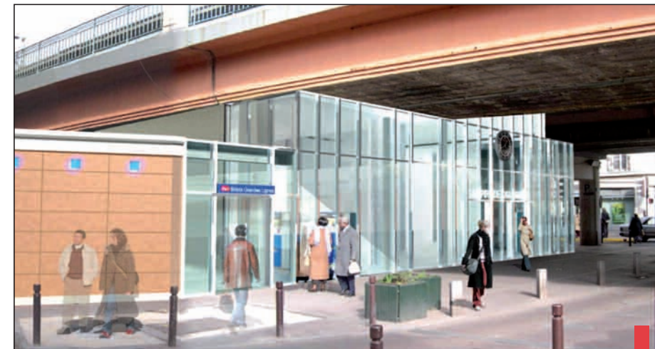
En multipliant les façades vitrées, le projet de modernisation de la gare de Colombes met l'accent sur la luminosité.
