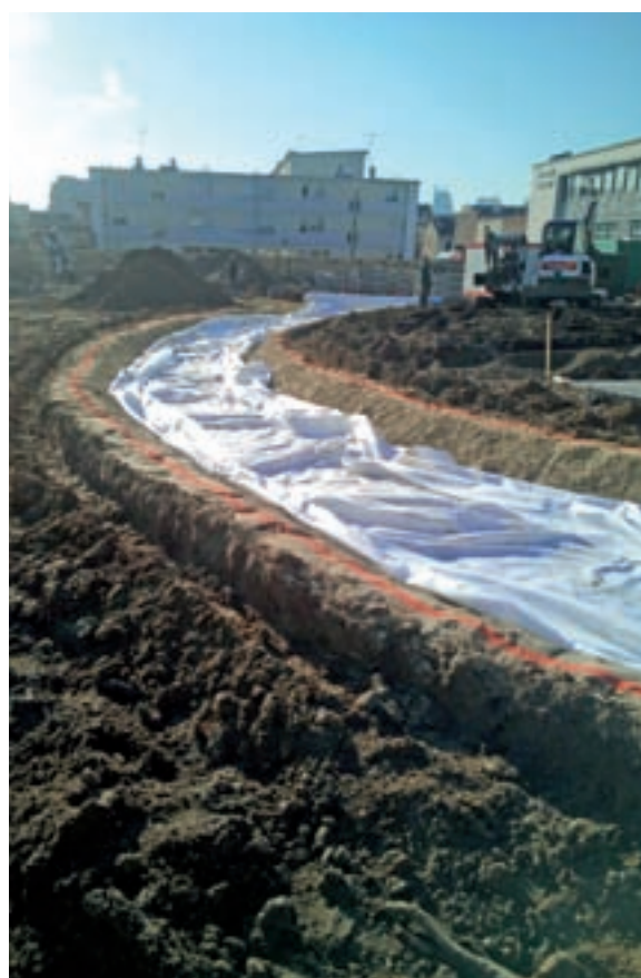
► Situé entre les rues Chatou et des Gros-Grès, le parc sera ouvert au public fin avril. Ici, le lit de la future rivière, longue d'une centaine de mètres.
