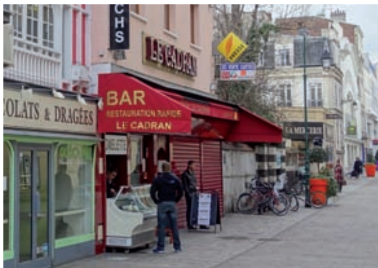
► Située à l'entrée de la rue Saint-Denis, l'îlot dit du Cadran se caractérise aujourd'hui par son manque de surfaces commerciales, et un bâti ancien et vétuste.
