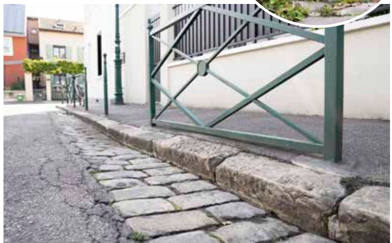
► Prévenus notamment par courrier, les riverains ont déplacé leur véhicule la veille de l'opération, permettant un nettoyage et un désherbage complet de l'espace public.
