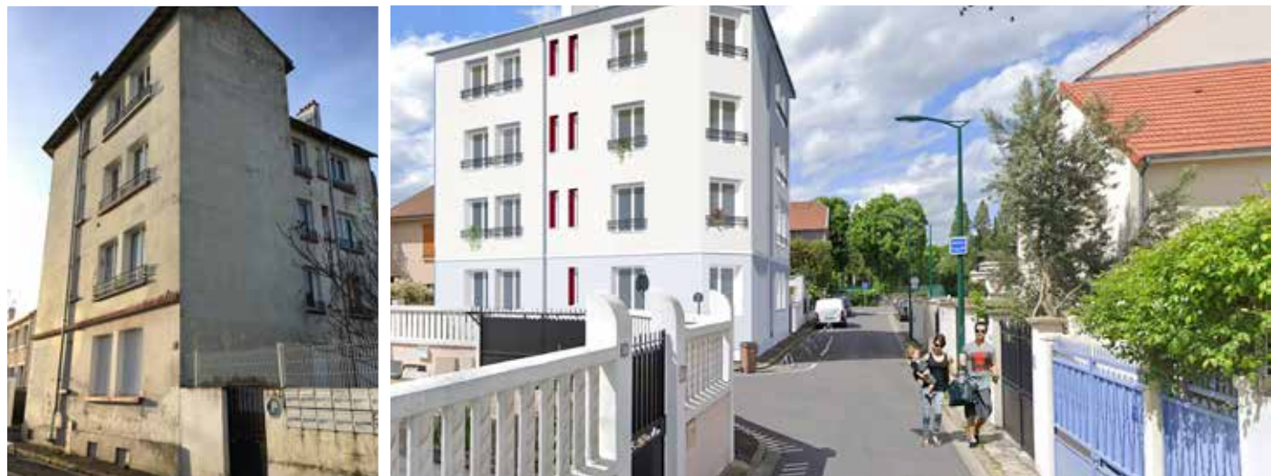
L'immeuble insalubre du 21, rue de l'Avenir, préempté fin 2018, va être transformé en 12 logements locatifs sociaux. Crédit perspective : Cuadra architectes
