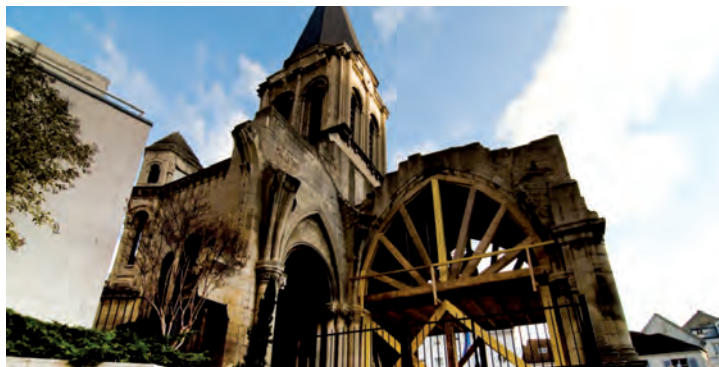
Le futur chantier devrait concerner à la fois la consolidation du sous-sol ainsi que celle des pierres de l'édifice.
