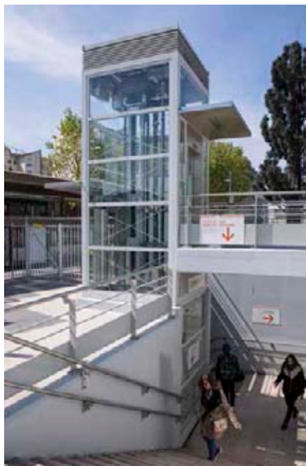
► Un ascenseur dessert désormais les trois niveaux de la gare : souterrain, parking et quais, passerelle. Photo Alexis Goudeau
