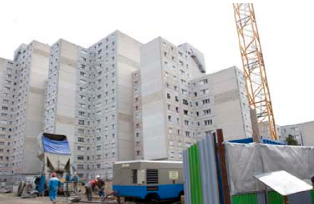
Les deux rencontres des conseils de quartier se dérouleront autour d'un cocktail et autour d'une galette: seront évoqués les préoccupations des habitants et les projets comme ici le chantier des Grèves.
