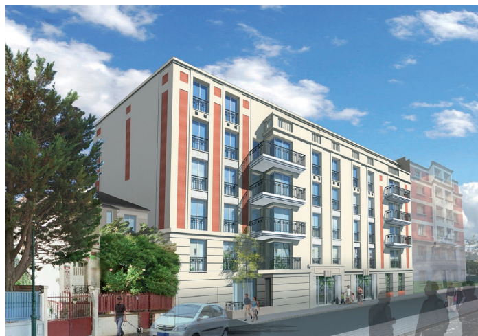
► Toutes les façades sont traitées dans une unité de couleurs sans faire de distinction entre la façade principale sur la rue Félix-Faure et celles face aux jardins Image : société Franco Suisse.
