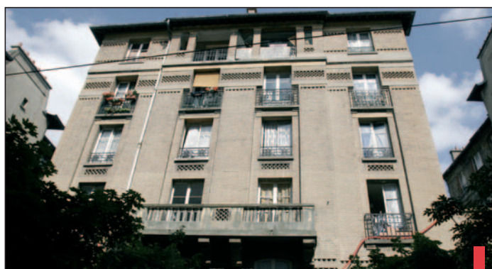
La résidence réhabilitée du 1-2 rue de Strasbourg.
