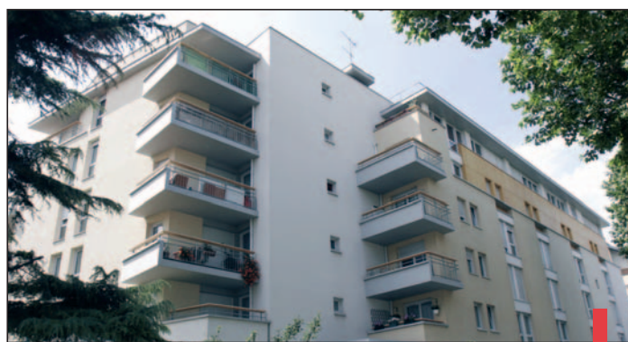
L'immeuble reconstruit du 23-25 rue Paul Bert.
