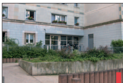
Un manque de visibilité des halls d'entrée.
