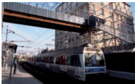
► La passerelle sera en service pendant la durée des travaux.
