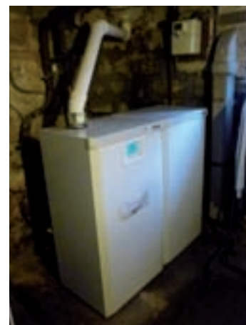
► L'ancienne chaudière a été remplacée par une chaudière gaz à condensation et une ventilation mécanique contrôlée a été installée. Photos Soliha
