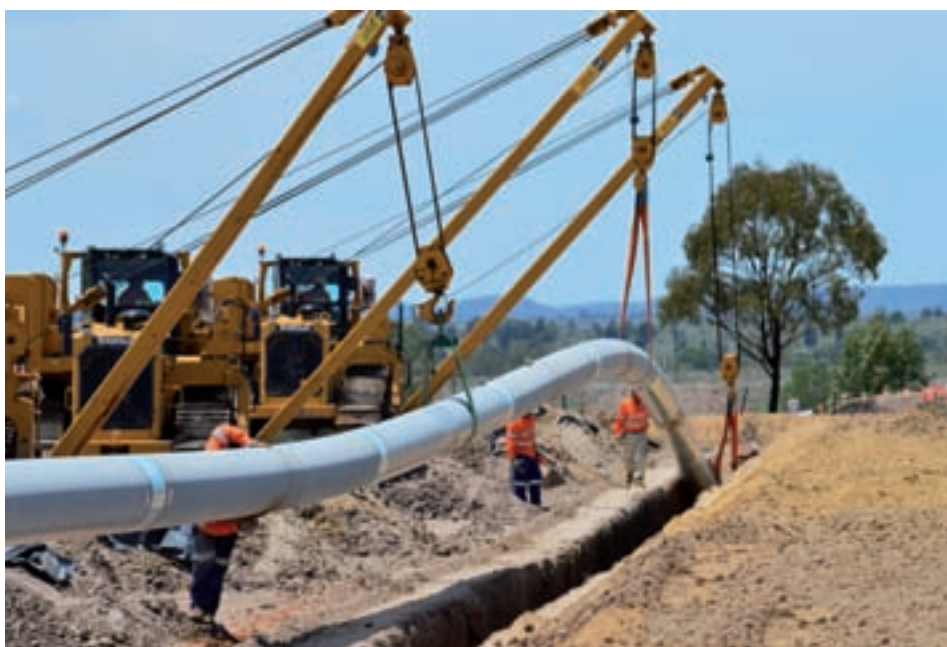
► Installée au parc Kléber, Entrepose réalise des projets clés en main pour l'industrie de l'énergie dans le monde entier, comme ici avec l'installation d'un pipeline en Australie.
