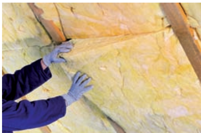
► Les ménages concernés par les travaux d'amélioration thermique réalisent un gain énergétique de 39 % en moyenne.
