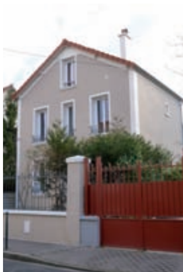
► Ici un pavillon colombien dans lequel des travaux ont été réalisés durant 6 mois. Les subventions ont couvert 45 % du coût. Photo Soliha
