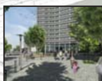
Édifice remarquable du quartier, la tour Z va être réhabilitée. L'entrée de l'immeuble va pour sa part être modifiée.
