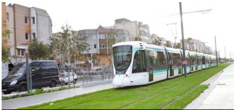
Le tramway T2 est prolongé de 4,2 kilomètres au nord entre La Défense et Bezons. Il traversera Courbevoie, La Garenne-Colombes, Colombes, Nanterre et Bezons.
