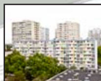
Après concertation avec les habitants, il a été décidé de démolir l'immeuble du 35 rue Michelet : 100 familles vont ainsi être relogées à Colombes.
