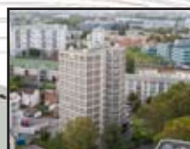
La Tour du 179, avenue Stalingrad, doit bénéficier de lourds travaux de réhabilitation : isolation thermique, ravalement de façade, etc.
