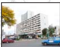
C'est à l'entrée de la rue Michelet que va être créé un nouveau cœur de quartier, qui nécessitera la démolition du patio, et la construction d'un nouveau parvis.
