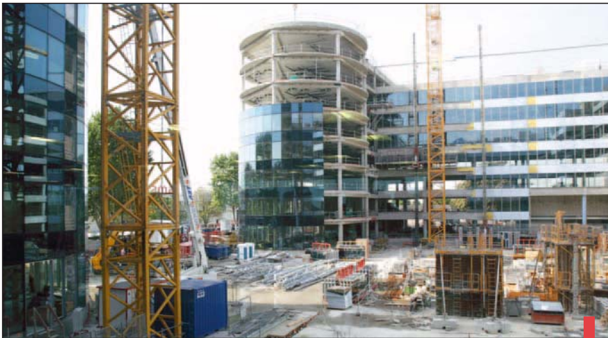
Le chantier HRO, conduit par l'entreprise Fougerolle, filiale d'Eiffage construction, avance à pas de géant.
