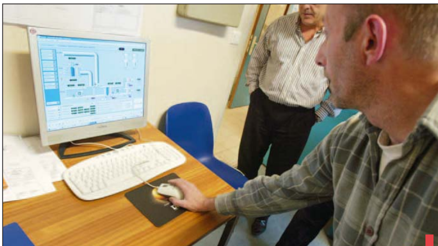
L'échangeur thermique entre la piscine et la patinoire est piloté par ordinateur.
