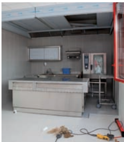
► L'extension comprend une cuisine qui servira de salle pédagogique pour le public.
