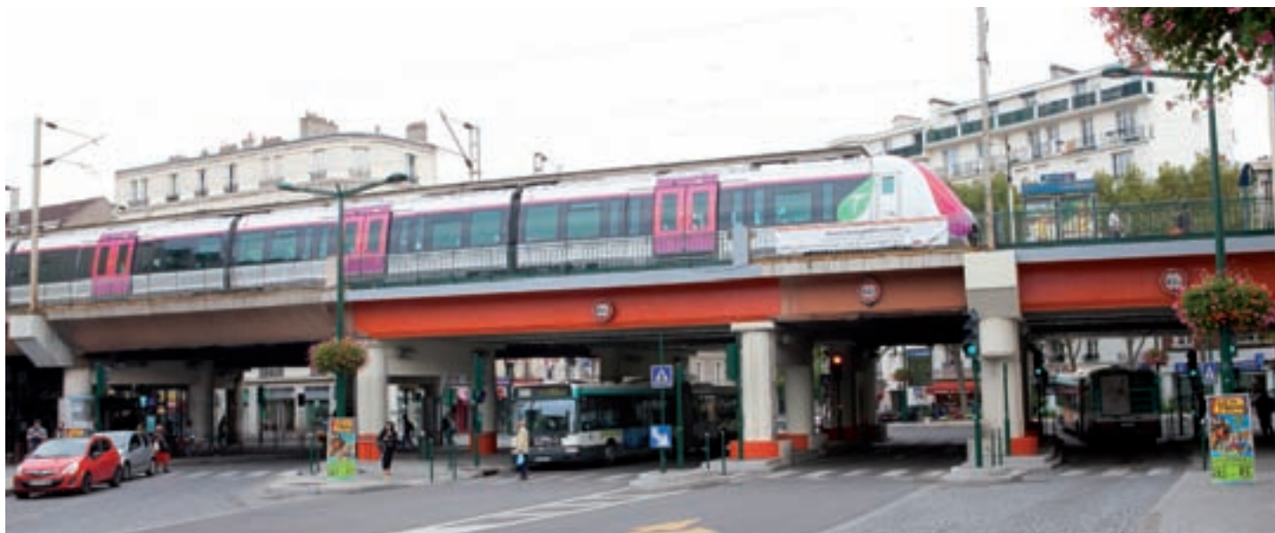
► Une première phase de mise en peinture du pont de la gare a été effectuée cet été. La deuxième phase aura lieu en 2015.
