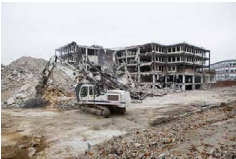
► L'îlot Cook, acquis en 2016 par la Ville pour 10 millions d'euros, a été déconstruit entre septembre et octobre. Photo Alexis Goudeau
