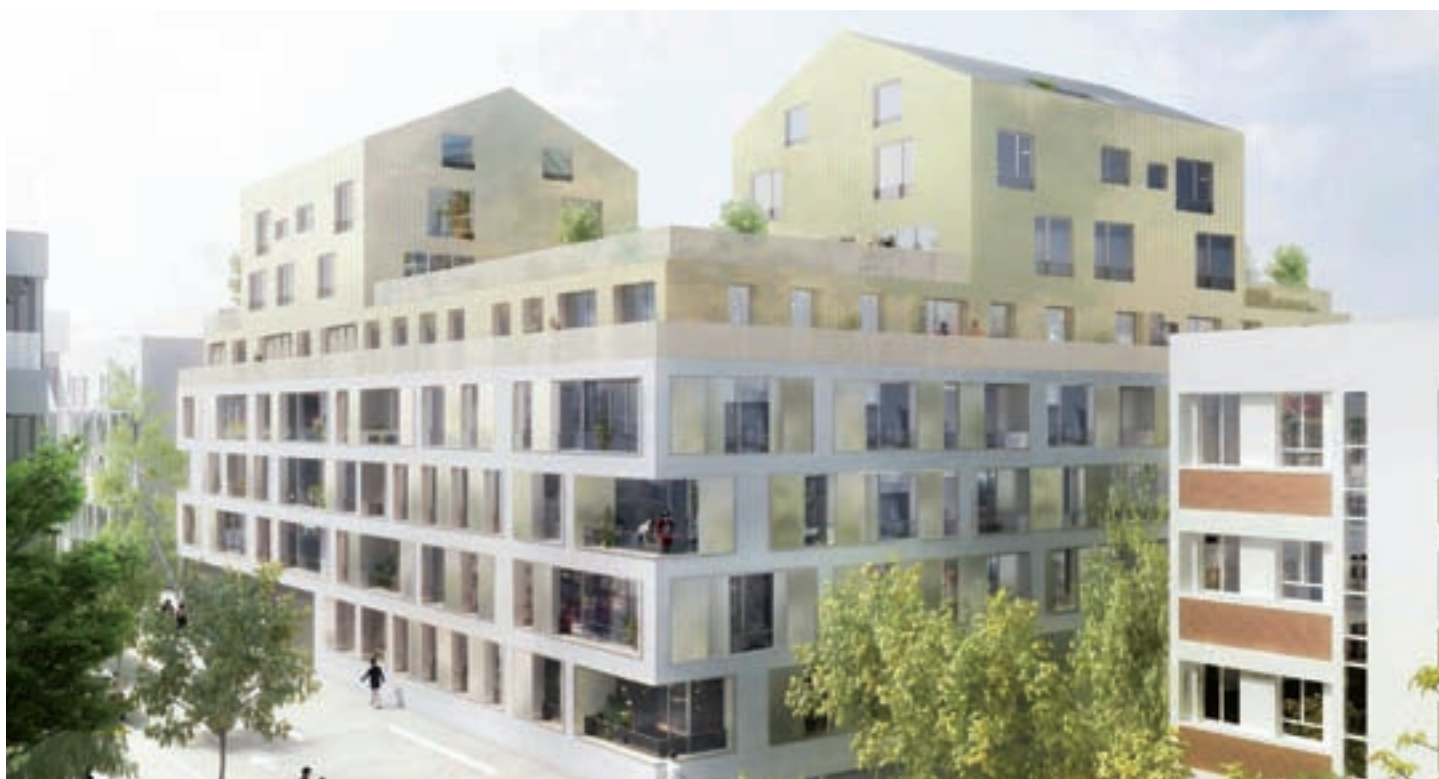
► Ce nouvel ensemble de logements sociaux reprendra la forme caractéristique de « maison posée sur le toit », déjà présente avenue de l'Europe. Image : Ameller et Dubois Architectes
