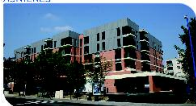
Construction de 40 logements sociaux et réalisation, pour le compte de la Ville d'Asnières, de volumes destinés à accueillir une maison des associations, une antenne de police municipale et une rocade de quartier. Livraison en 2011.
