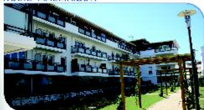
Opération mixte de construction de 59 logements sociaux et de 60 logements en accession sociale à la propriété. Livraison en 2011.
