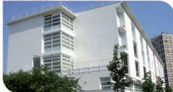
Etablissement d'Hébergement pour personnes âgées dépendantes Résidence Marcelle Devaud
