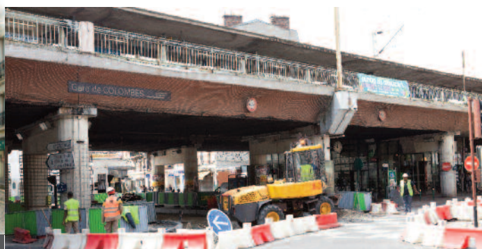
Le pavage du « pôle gare », qui impose un temps de séchage de plusieurs semaines, a déjà débuté.
