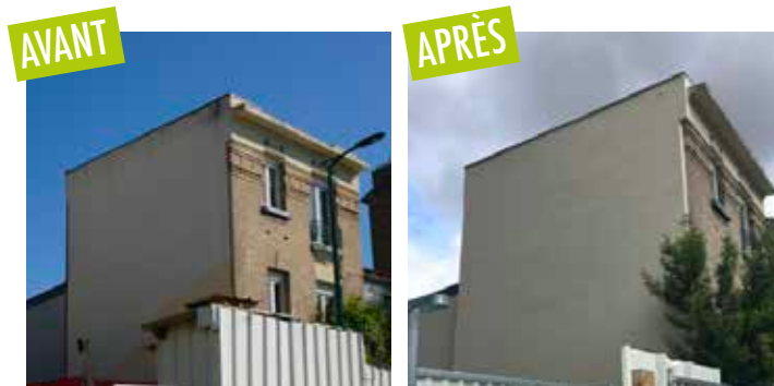
► Les habitants de ce pavillon colombien ont pu faire financer 62 % de leurs travaux d'amélioration thermique (ravalement avec isolation par l'extérieur et pose d'une VMC hygroréglable).
