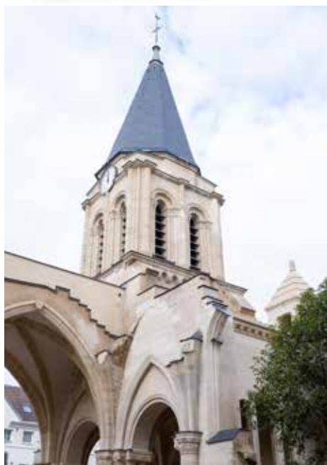
► Depuis la dépose de l'échafaudage en novembre dernier, les passants peuvent admirer le nouveau revêtement de l'édifice, entièrement ravalé. Photos Alexis Goudeau
