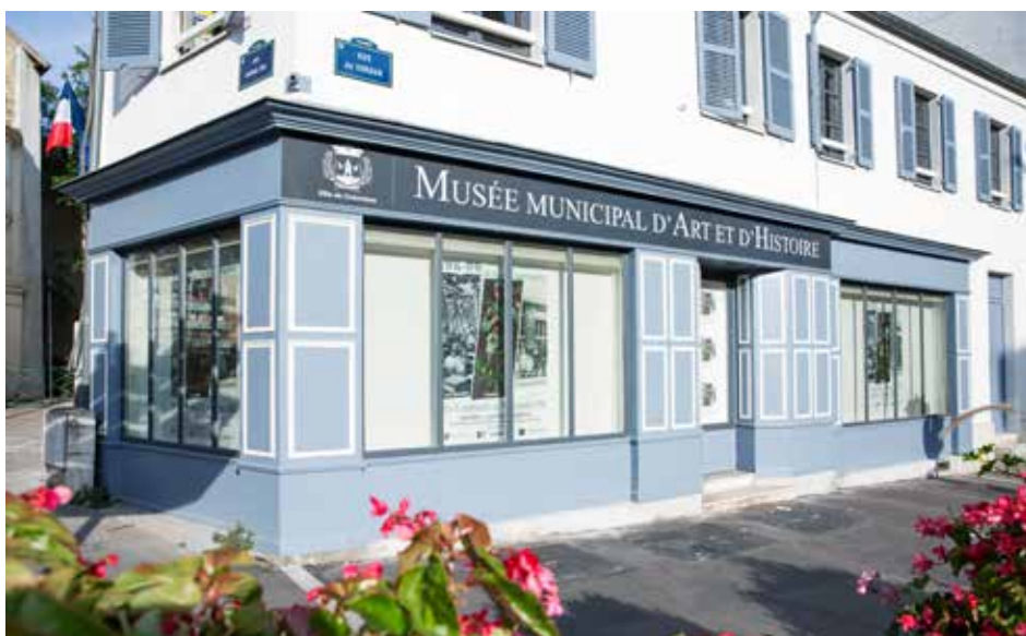
► Une partie des locaux au rez-de-chaussée est désormais accessible aux personnes à mobilité réduite avec la création d'une banque d'accueil et de toilettes adaptés.
