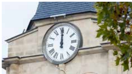
► Les cadrans de l'horloge et les aiguilles ont été restaurés.
