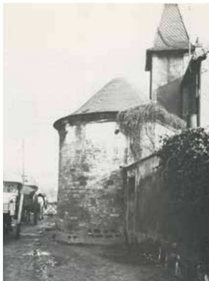
► La tour, sise rue Gambetta, desservait l'ancienne entrée du parc du domaine Courtanvaux. - © Archives communales
