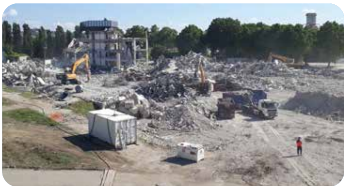
► Sur le site Columbus le béton concassé servira de remblais. Photo :
