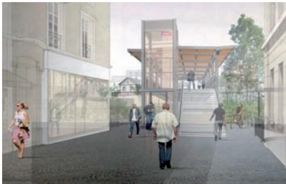
► Vue sur la nouvelle passerelle depuis la rue des Vallées avec un ascenseur pour les Personnes à Mobilité Réduite (Image : SNCF Conception & Réalisation).
