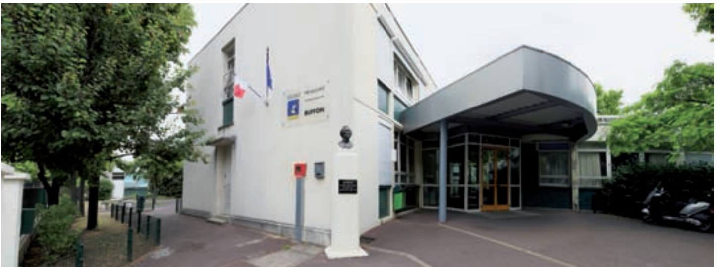
► Outre la réfection de sa toiture, le groupe scolaire Buffon verra son préau refait durant les mois de juillet et d'août.
