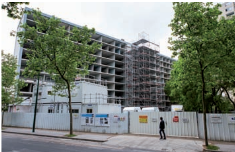
► L'immeuble a été désamianté ces derniers mois, un étage après l'autre. Sa démolition peut maintenant commencer sans risque. Photo Alexis Goudeau
