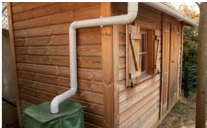
► Le récupérateur d'eau est raccordé à une gouttière et peut être installé aussi bien en extérieur (notre photo) qu'en sous-sol, ou même, être enterré.
