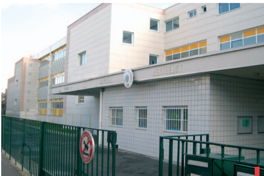
Neuf millions d'euros de travaux sont prévus pour le groupe scolaire Marcelin Berthelot.
