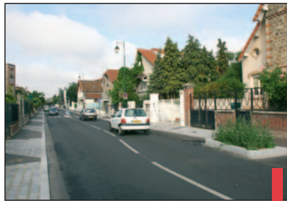
La « nouvelle » rue du Progrès.
