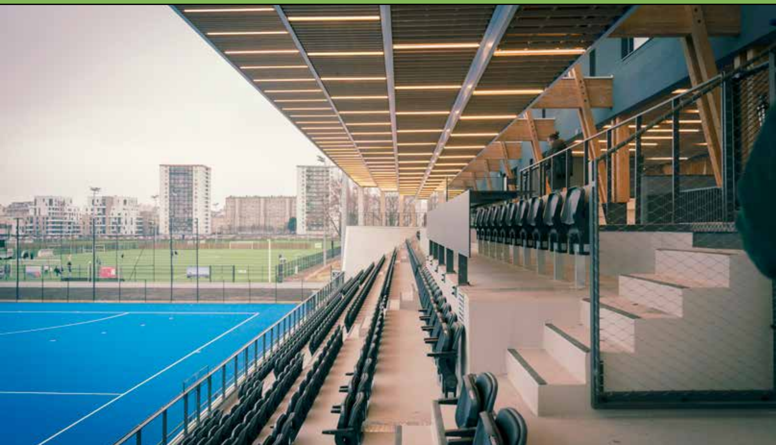
En bordure de l'édifice historique, une tribune couverte de 1000 places. Elle s'intègre dans un bâtiment flambant neuf qui comprend des vestiaires, des locaux administratifs et des salles de réception et de musculation. © Dragos Schenkel
