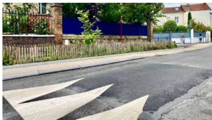
Ralentisseurs mis en conformité rue d'Estienne-d'Orves et rue des Voies-du-Bois pour moins de nuisances sonores et un meilleur confort pour les riverains.
