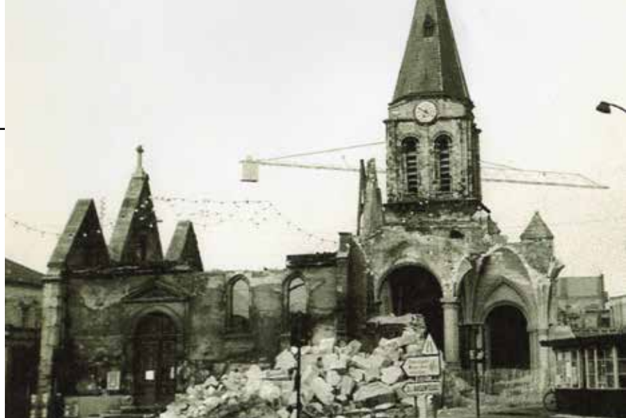
Démolition de l'ancienne église Saint-Pierre-Saint-Paul - 1968 Collection Musée d'Art et d'Histoire de Colombes
