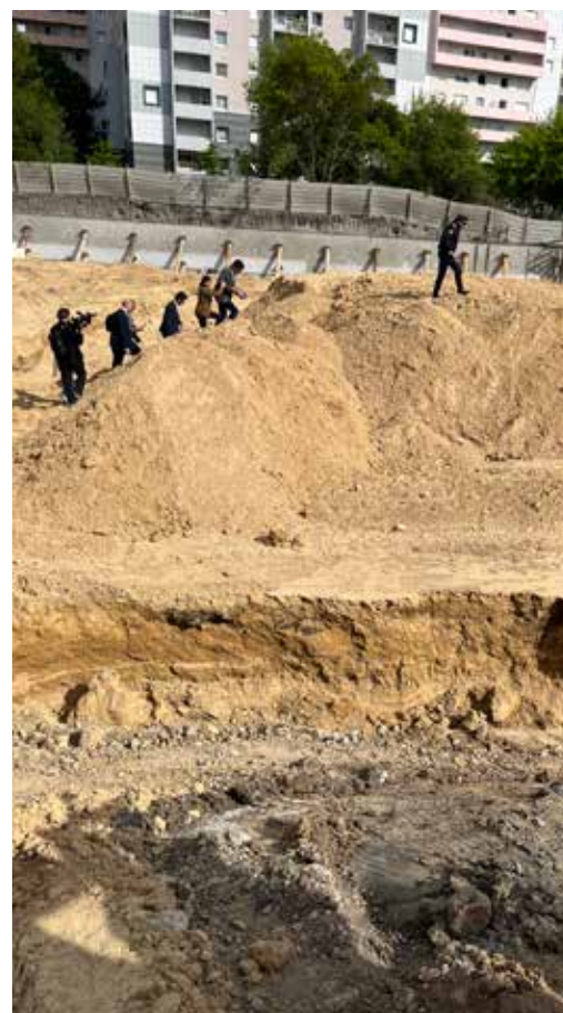
Chantier du 148, rue des Champarons à l'issue de l'opération de déminage.
