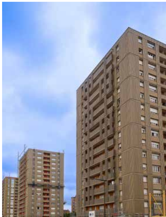
Les appartements des tours Audra, en cours de rénovation énergétique par le bailleur Colombes Habitat Public.
